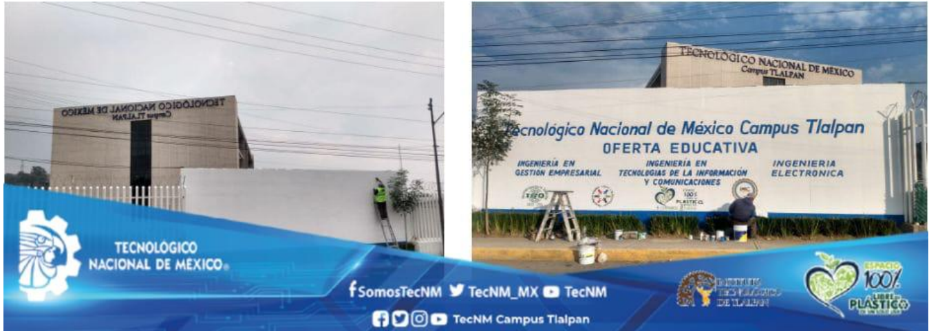
Figura 24. Se realizan trabajos de aplicación de pintura blanca y azul en barda de concreto ubicada en la entrada principal del Instituto Tecnológico de Tlalpan colocando la oferta educativa
